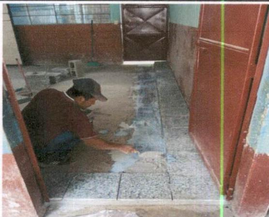
Foto 3: Inicio de instalación de piso de granito en las aulas de Preprimaria
